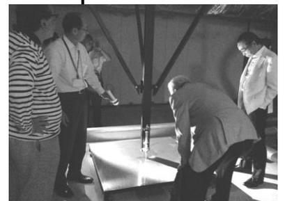
低層部の商業階と高層部の住宅階の間に設けられた中間免震装置を見学しました
