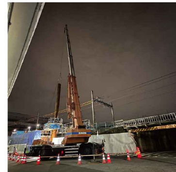
法面防護管設置の様子
