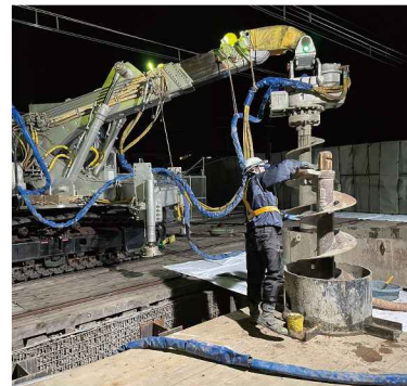
仮土留杭設置の様子
