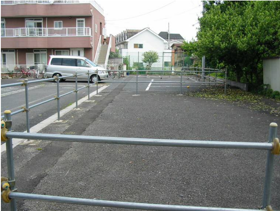
しぶえ南アクセス道路 (施工前)
