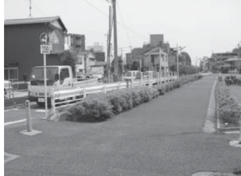
暗渠化された上下之割用水
