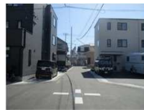
整備後の拡幅された道路
