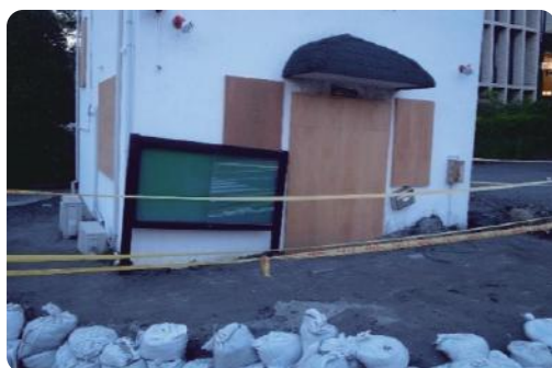
建物が右側へ大きく沈下して傾いています。 出典：浦安市立中央図書館「浦安震災アーカイブ」
