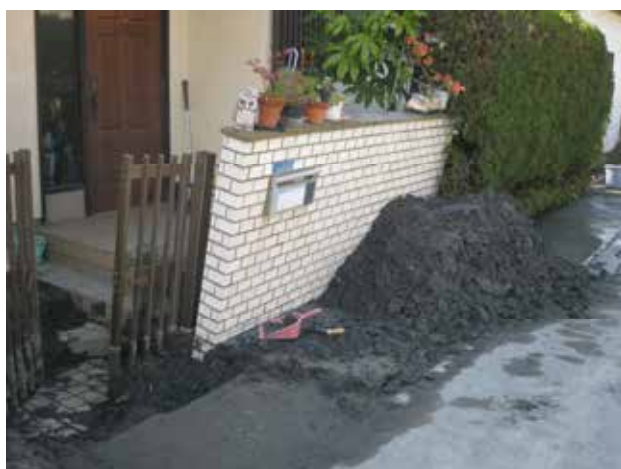
※道路とブロック塀の境目から出た噴砂が入口付近にたまっています。
