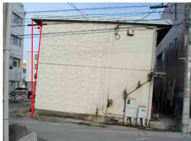
※建物が右側へ大きく沈下して傾いています。
