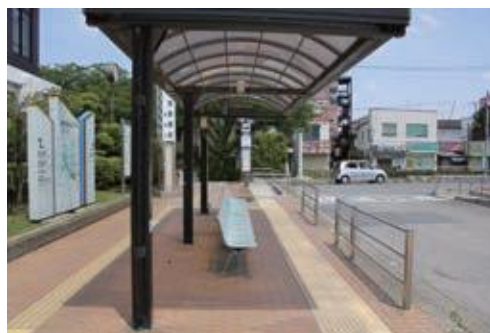
写真 上屋などの設置例
