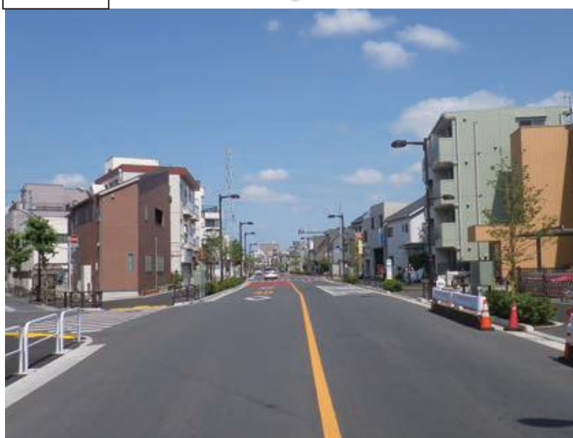
写真 整備後の都市計画道路補助第 264 号線（細田東）区間
