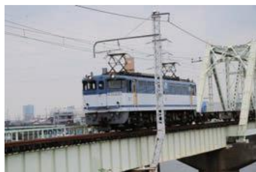
写真 新金貨物線（中川放水路橋梁付近）
