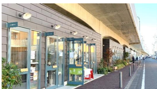
東小金井駅付近
