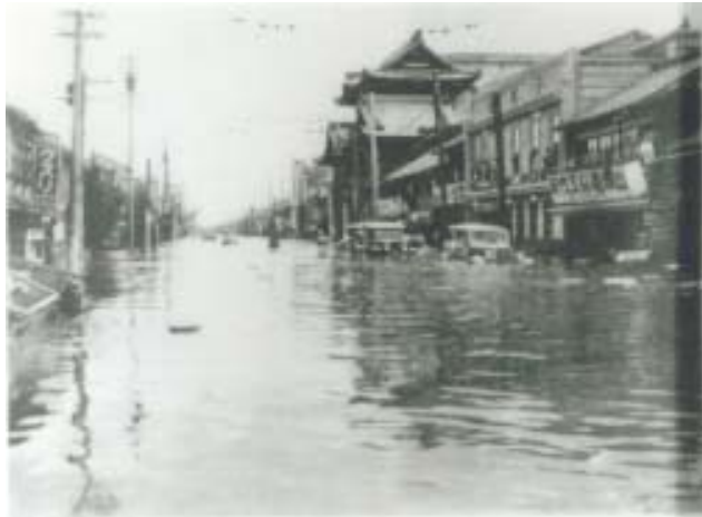
冠水した道路
