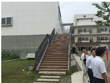
体育館と校舎に接続している階段
