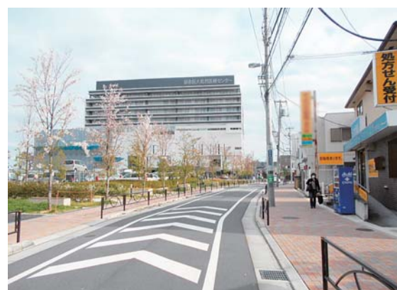
整備工事完了後
