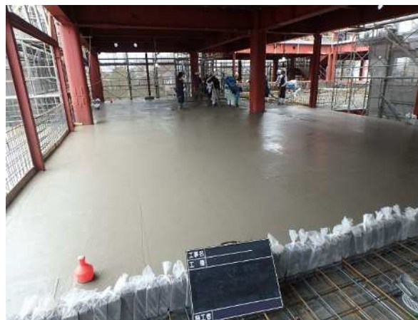
床コンクリート
