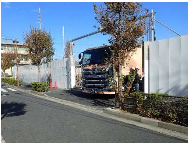
仮囲い(成型鋼板) シートゲート
