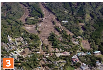
平成25年10月台風26号(大島町) 大島町元町地区を襲った土石流の状況 死者・行方不明者: 39名
