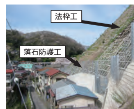
急傾斜地対策
