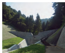
土石流対策(砂防堰堤)
