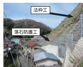
急傾斜地対策
