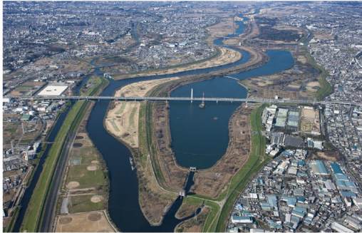
荒川第一調節池（埼玉県戸田市、さいたま市） 洪水調節容量 約3,900万m 3
