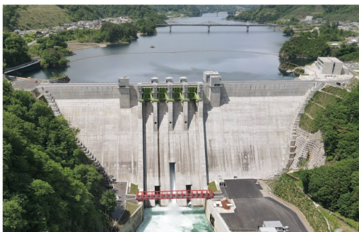
利根川上流部のハツ場ダム（群馬県吾妻郡）
