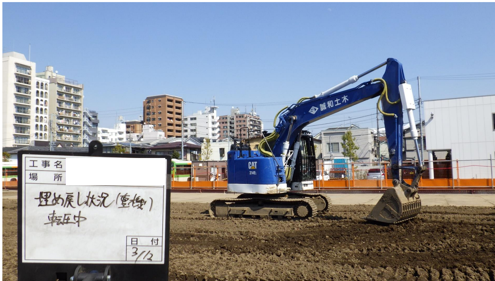
他現場の参考例（整地状況）
