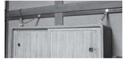
▲たんすに設置した転倒防止器具
