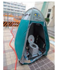
▲マンホールトイレ
