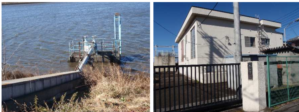
写真 2 取水・導水施設（左：中川の取水施設、右：導水施設）
