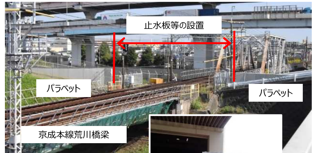
パラペットに連結させる止水板
