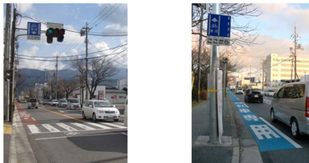
図 道路標識及び道路標示の設置事例
