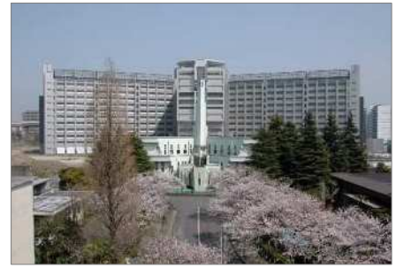
東京拘置所の外観
