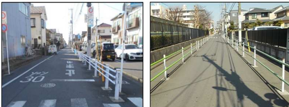
写真 2-3 防護柵による歩車道分離(フラット形式)「準歩道」
