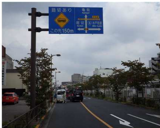
写真 2-10 道路標識（左：片持式（大型）、右：路側式）
