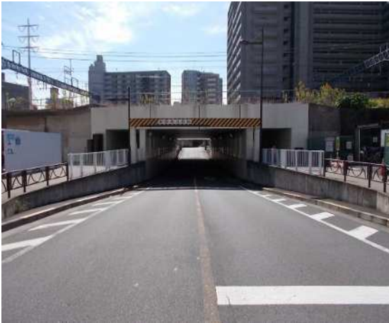
金町駅東側南北道路
