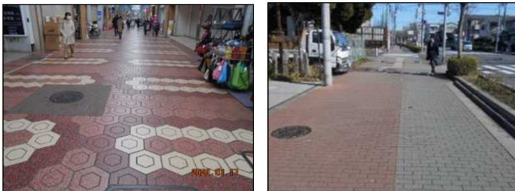
写真 2-4 カラー舗装 左:車道舗装 右:歩道舗装
