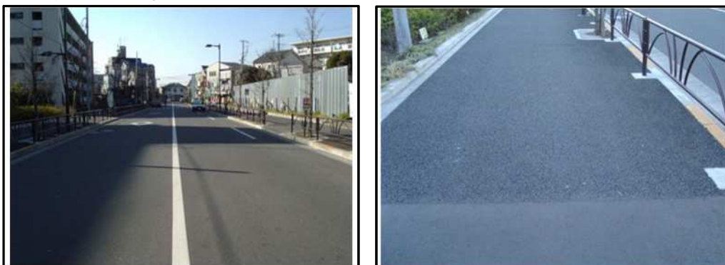
写真 2-2 左:車道舗装 右:歩道舗装
