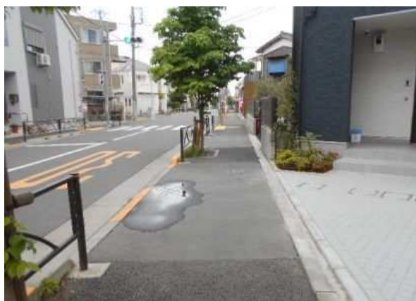
写真 3-2 損傷状況の例（ランク II）
