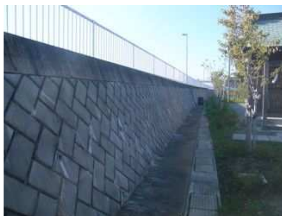
ブロック積擁壁
