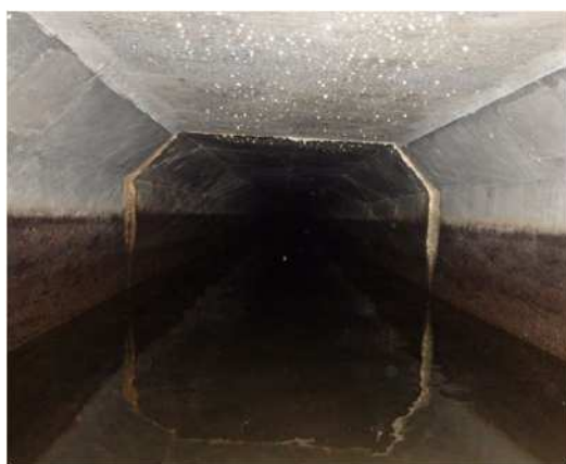
写真 2-6 排水施設（水路・暗渠）
