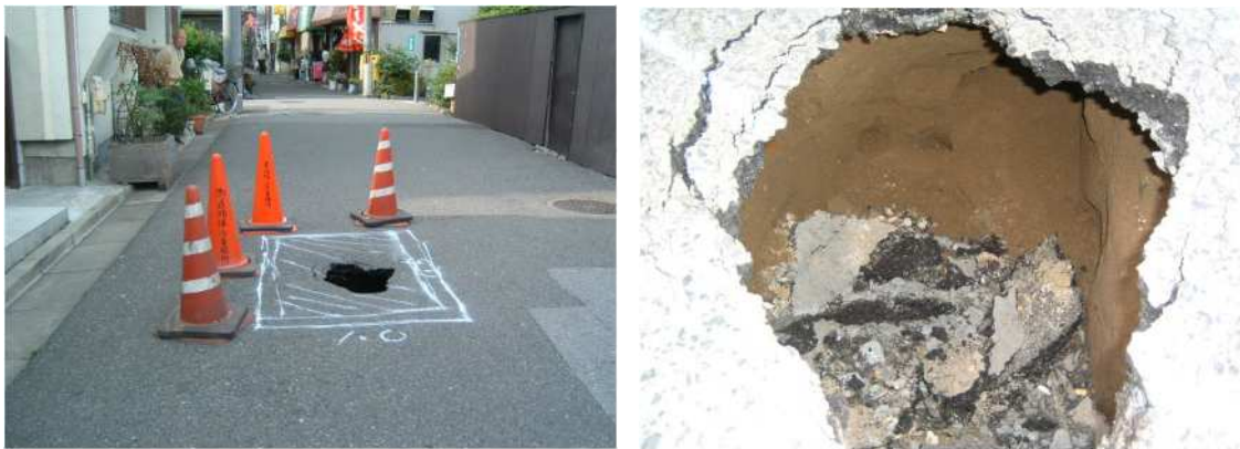
写真 3-1 取付管の損壊による空洞が原因と推定される道路陥没箇所
