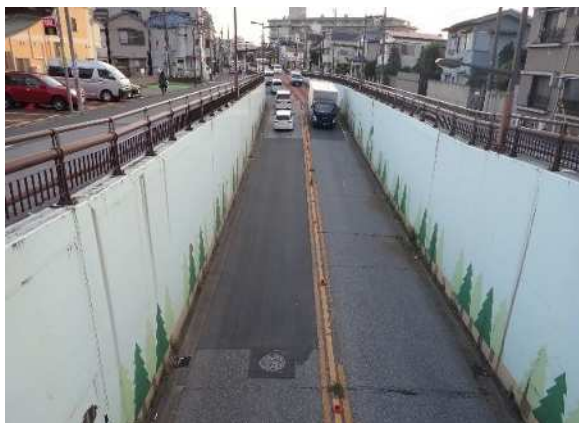
コンクリート擁壁
