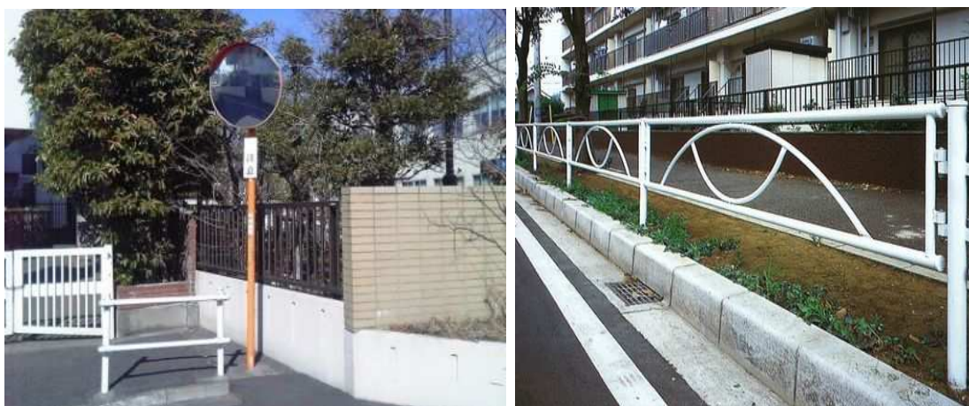
写真 2-12 その他の道路附属物 (左: 道路反射鏡 右: 防護柵)
