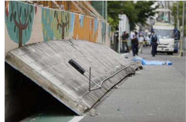
平成30年の大阪北部地震では、高さ1.6mのブロック塀の倒壊により女児が死亡
