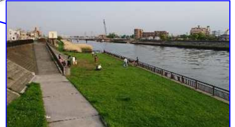
新中川高水敷の利用状況
