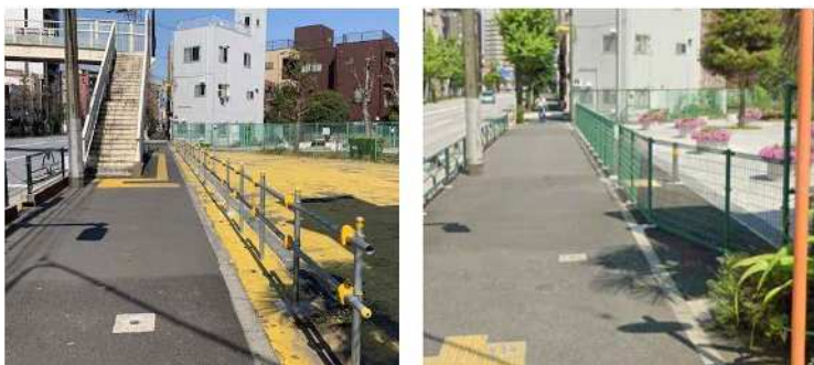
既存公園隣接地を買収して公園拡張した例 (東向島北公園 左：買収前 右：買収後(整備後))
