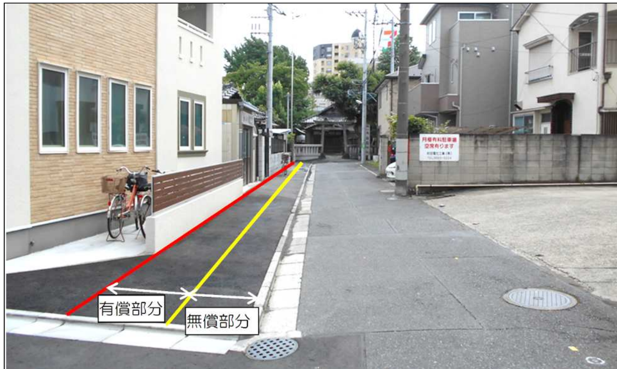
道路用地の取得による主要生活道路（6m）の整備
